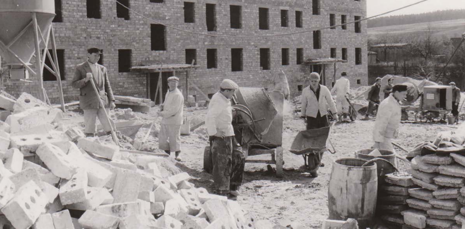
Erste Wohnungen in Tiefengruber Straße; damals legten die Genossenschaftler noch selbst Hand an
