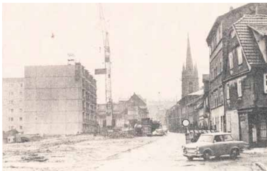
Antang März wird Block 8 der Wohnungsbaustelle Goethestraße bezugsfertig. Die Montage der 48 Wohneinheiten des an die Sophienstraße angrenzenden Blocks ist abgeschlossen, mit dem Ausbau wurde bereits begonnen, und am kommenden Montag werden schon die Dachdecker und Fußbodenleger ihre Arbeit in Angriff nehmen. Nur noch acht Wochen also bis zur Schlüsselübergabe. Foto: DV/Pfeiffer
