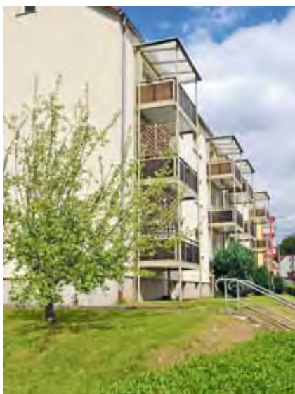
Bahnhofstraße 48 a–b in Creuzburg
