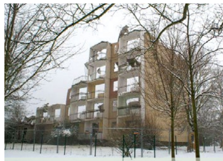
Abrissarbeiten im vergangenen Winter
