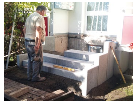
Bauarbeiten an den Hauseingängen Am Schleierborn 5–8
